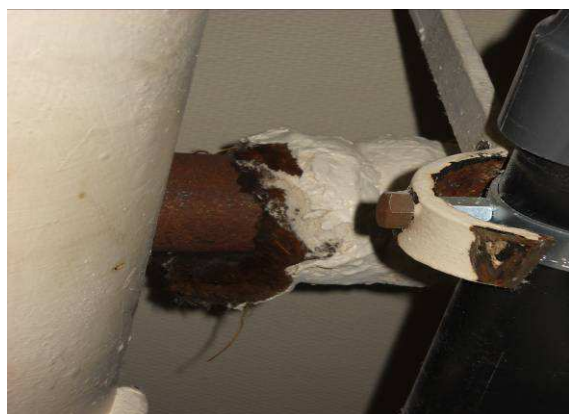
P69 : Calorifuge dans l'ancienne cuisine de la salle Descamps (grosse canalisation) – Photo N°68
