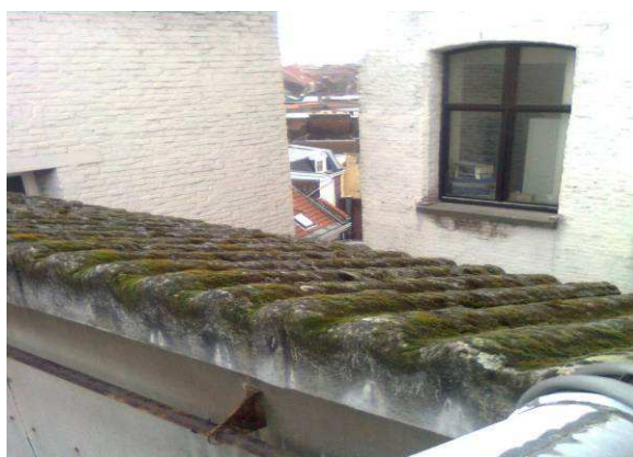
P 71 : Toiture de la passerelle du service informatique au 3 ème étage contenant de l'amiante – Photo N°70
